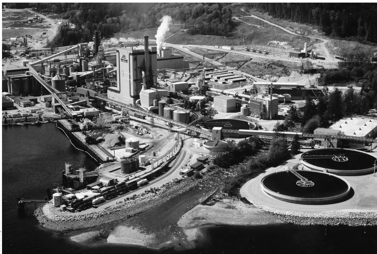
Figura 72.2 • Moderno complejo fabril de pasta y papel situado en la ribera de un río navegable.
