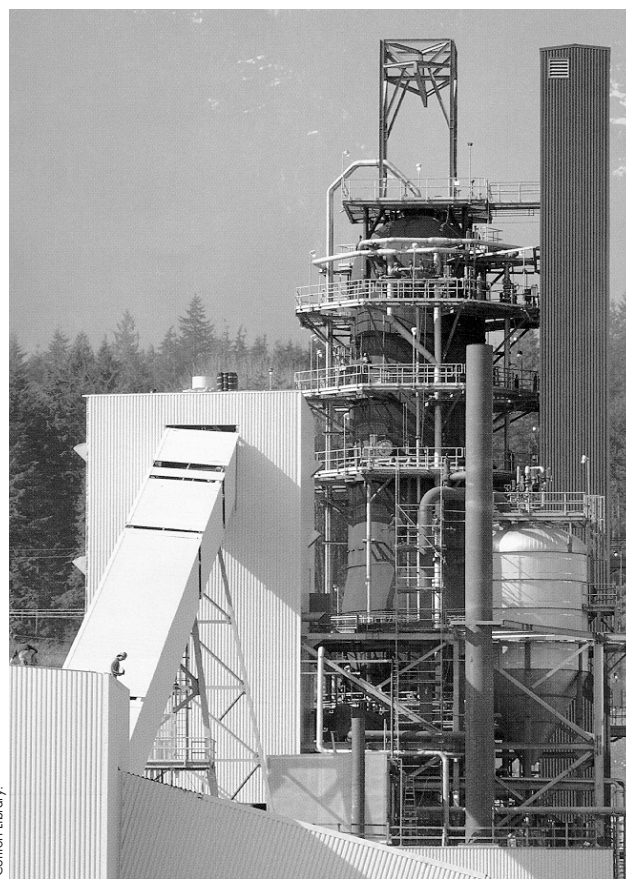
Figura 72.8 • Digestor continuo de kraft, con transportador de astillas en construcción.
