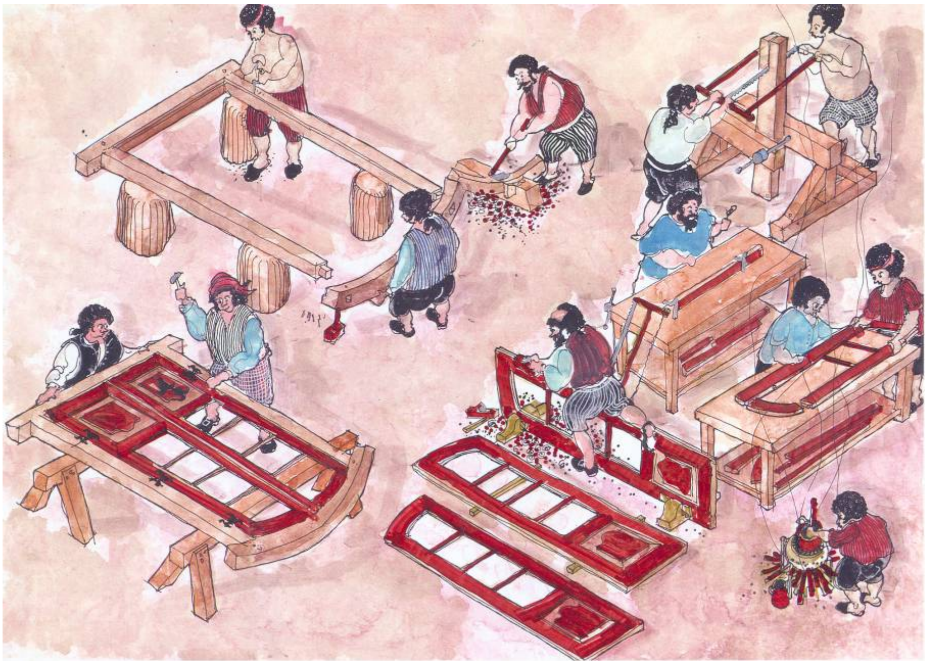
Fabricando puertas con arco escarzano (fines del siglo XVIII)
