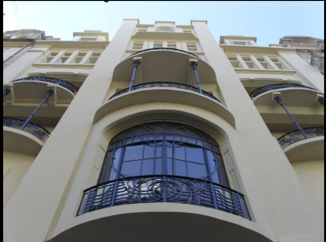
PALACIO VERA REHABILITACIÓN DEL FRENTE
