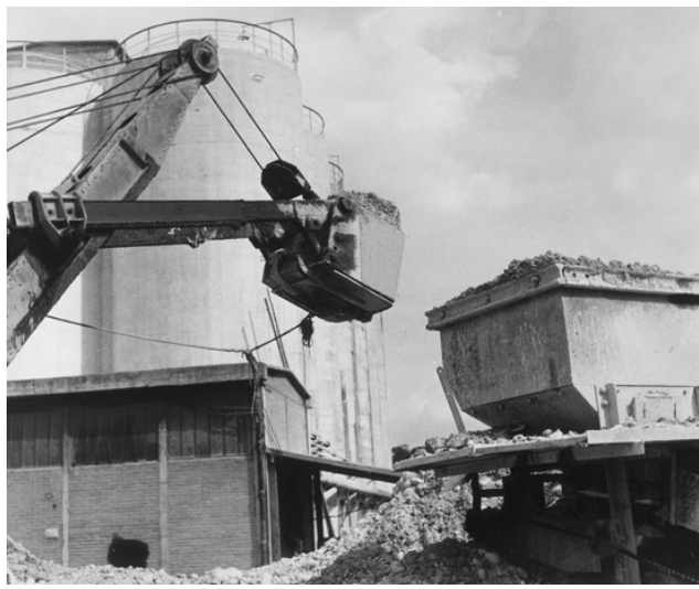
Figura 93.9 • Excavación mecánica en una obra en Francia.
